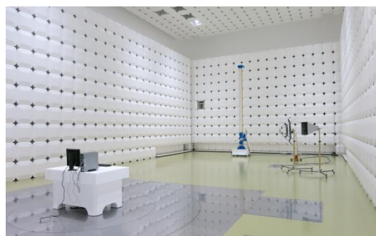
10m 法電波暗室
