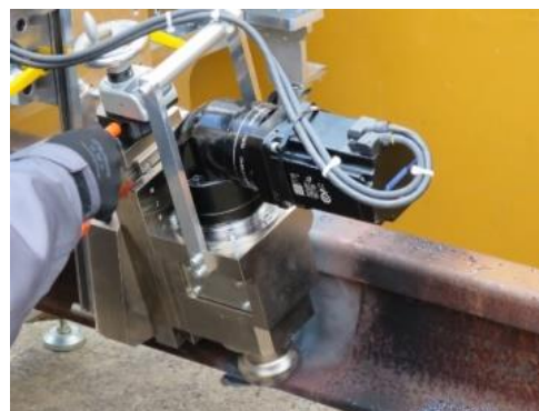
底部傾斜面の削正
